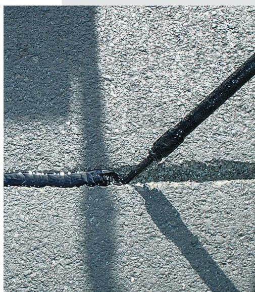
Компания **CRAFCO** предлагает широкую гамму заливщиков швов различных модификаций, которые полностью удовлетворяют всем вышеизложенным требованиям, а так же обладают такими важными функциями как: автоматический контроль разогрева мастики, электрообогрев шланга и аппликатора, регулировка скорости подачи мастики, возможность установки компрессора для подключения пневмо-пистолета или теплового копья.
