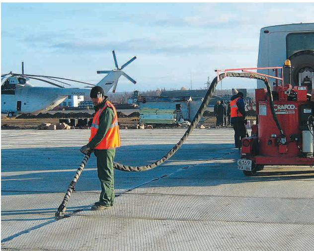
Наиболее эффективной эксплуатации машин способствует отсутствие линий, находящихся под постоянным давлением. Также отсутствуют клапаны, а количество движущихся частей сведено к минимуму. Подготовка установки к эксплуатации занимает около 45 минут.
